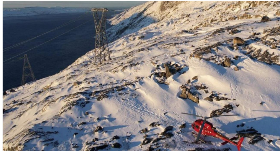
Figur 10: Ved nedbrud i elnettet, skal teknikere vente på vejforhold, der gør det muligt at benytte helikopter til at reparere kablerne.
